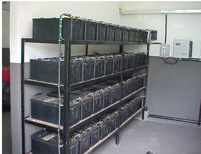
Figura 7.22 – Armário de baterias (Foto cedida pelo GEDAE/UFPA).
