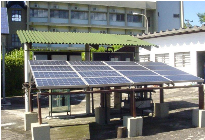
Figura 7.14 – Fixação da estrutura no solo com fundação tipo bloco de cimento (Foto cedida pelo LSF-IEE/USP).
