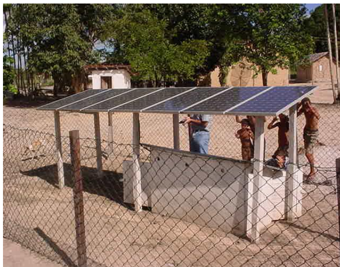
Figura A3.5 – Gerador fotovoltaico da escola de Bom Futuro. Fonte: GEDAE.
