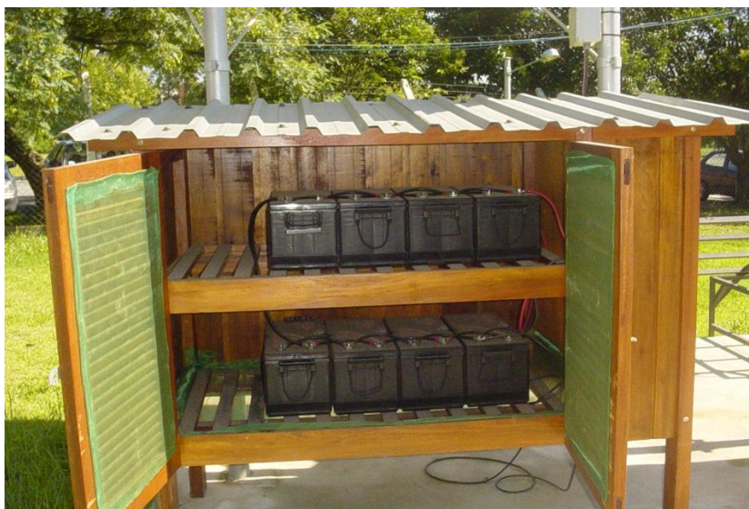
Figura 7.21 – Abrigo de madeira devidamente ventilado e isolado e com tela para impedir a entrada de pequenos insetos e animais (Foto cedida pelo LSF-IEE/USP).
