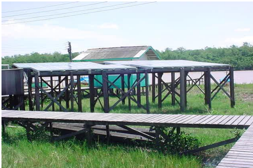
Figura 7.15 – Fixação da estrutura diretamente no solo (Foto cedida pelo GEDAE/UFPA).
