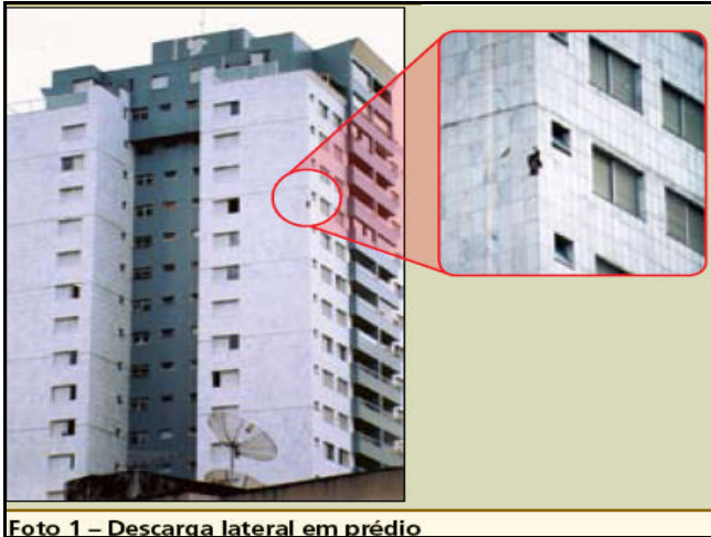
Foto 1 – Descarga lateral em prédio
