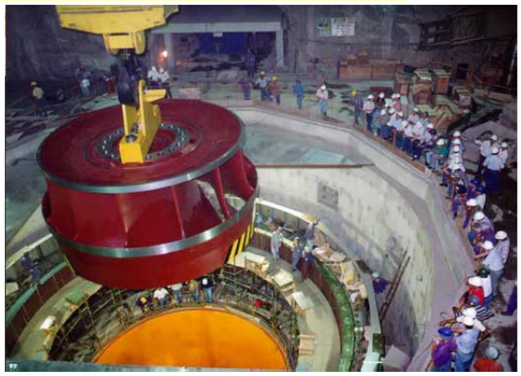
Colocação da Turbina hidráulica
