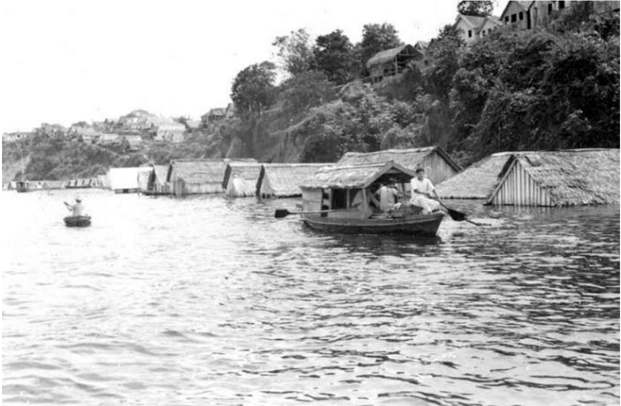
Imagem 47: Embarcação em frente as casas inundadas pela enchente em Manaus (AM). (Fonte: Biblioteca Digital do IBGE / Foto: Tibor Jablonsky, Lúcio de Castro Soares. 1953)
