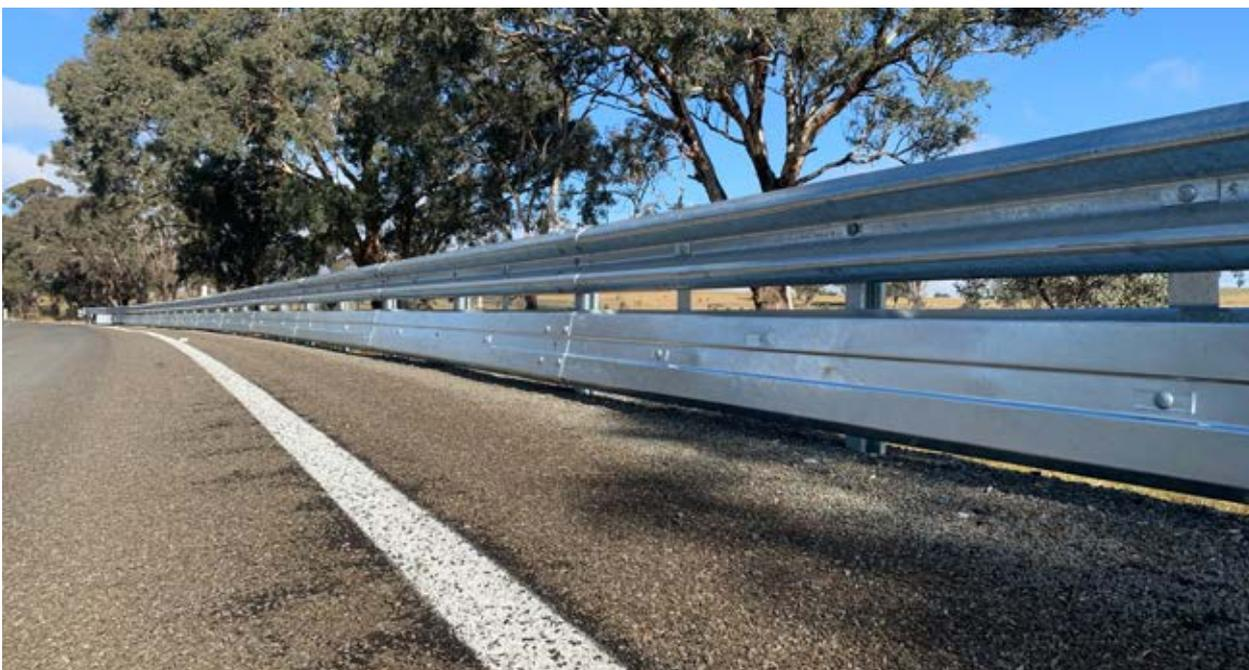
Todo sistema de contenção deve ser iniciado e encerrado com segurança. Dessa forma, as estruturas de defesa metálica, barreira de concreto ou barreira metálica
