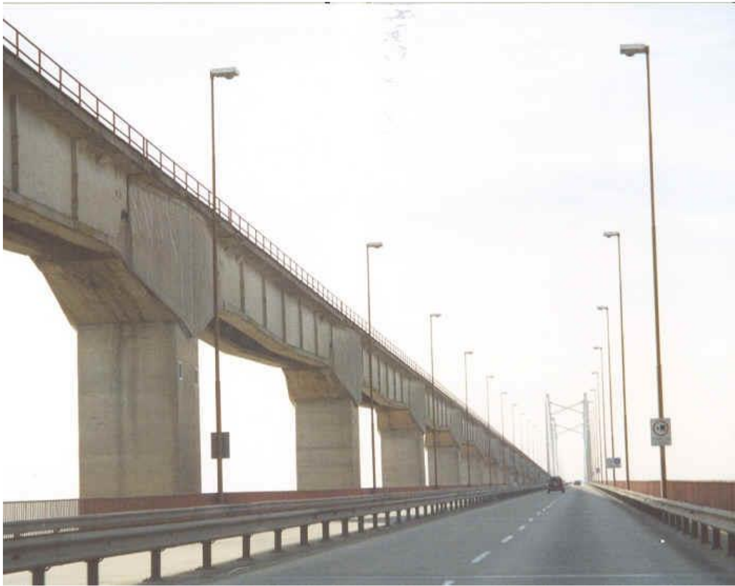
Ponte ferroviária Zarate Brazo Largo I sobre o rio Paraná de las Palmas, na Argentina, 1978
