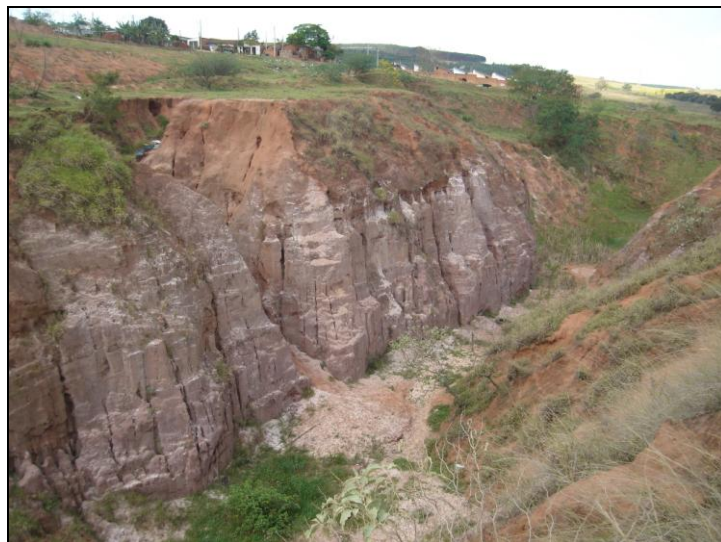
Foto 01 – Talude erosivo da voçoroca do córrego Tucunzinho (Fotografia tomada pelo autor em Janeiro de 2010)
