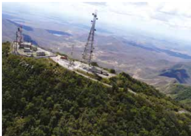
Figura 2.21 – Visão aérea do Pico Alto, o ponto mais elevado do maciço de Baturité (CE), que trata-se de uma crista sustentada pelo
