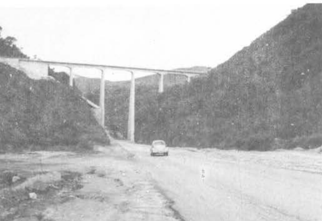
FOTO 24 — Fecho do Funil — garganta epigênica (gap) aberta por rio perpendicular ao eixo dos dobramentos dos quartzitos ferruginosos — Quadrilátero ferrífero — MG. — Foto da autora
