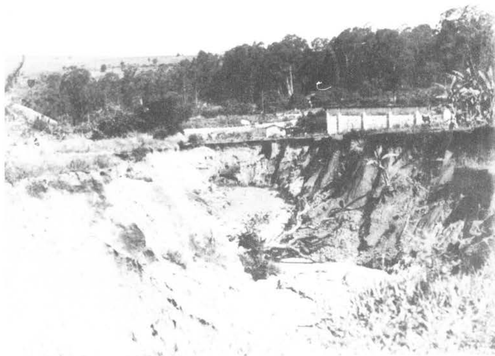
FOTO 40 — Voçoroca em sedimentos inconsolidados da bacia Pleistocênica de Rio Claro, SP em vertentes de 3° de declive. — Foto da autora
