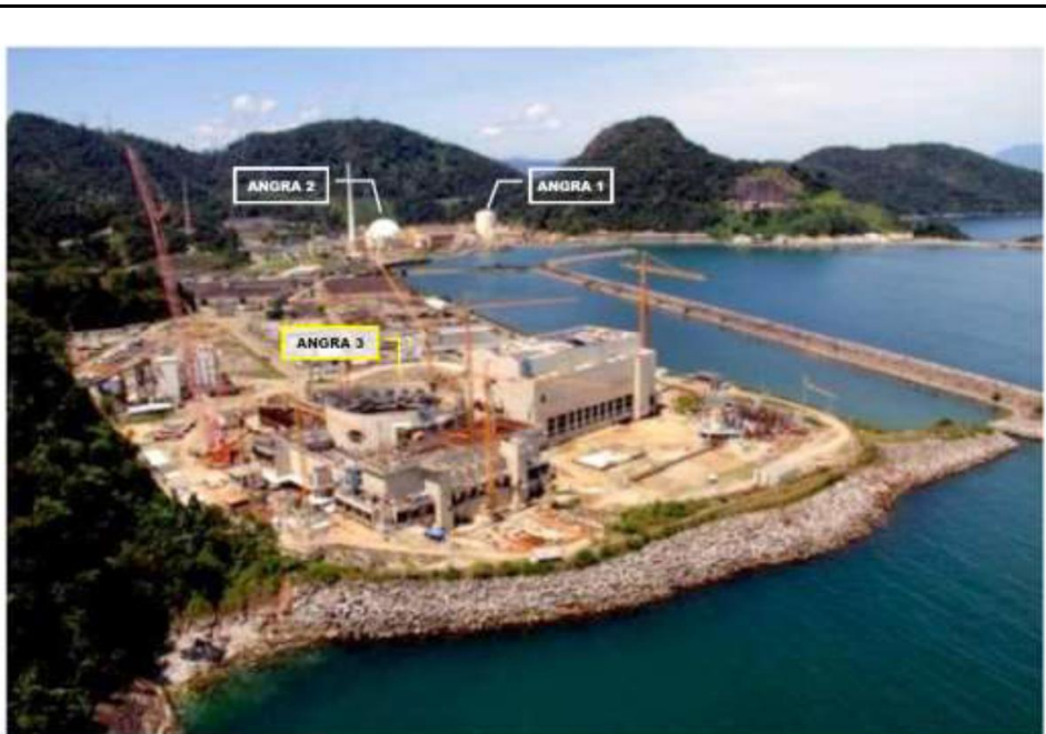
PRÉDIO DO REATOR DE ANGRA 3, EM FASE DE CONSTRUÇÃO.
