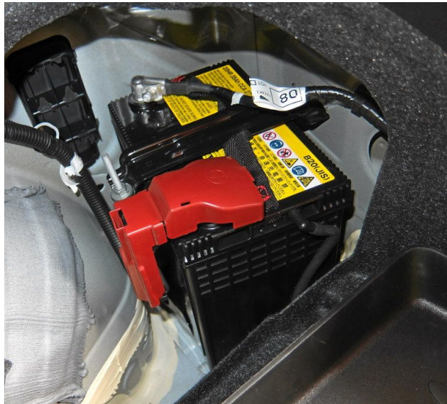
Figura 5.1.5 - Bateria auxiliar montada no Toyota Prius
