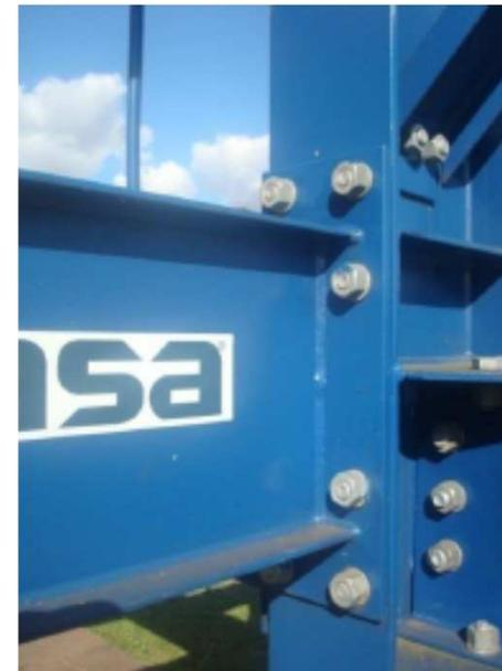
Fig. 5: Ligações “rígidas” (permitem a transmissão de momentos fletores e de forças entre os elementos estruturais: ligação viga-viga ou viga-coluna).
