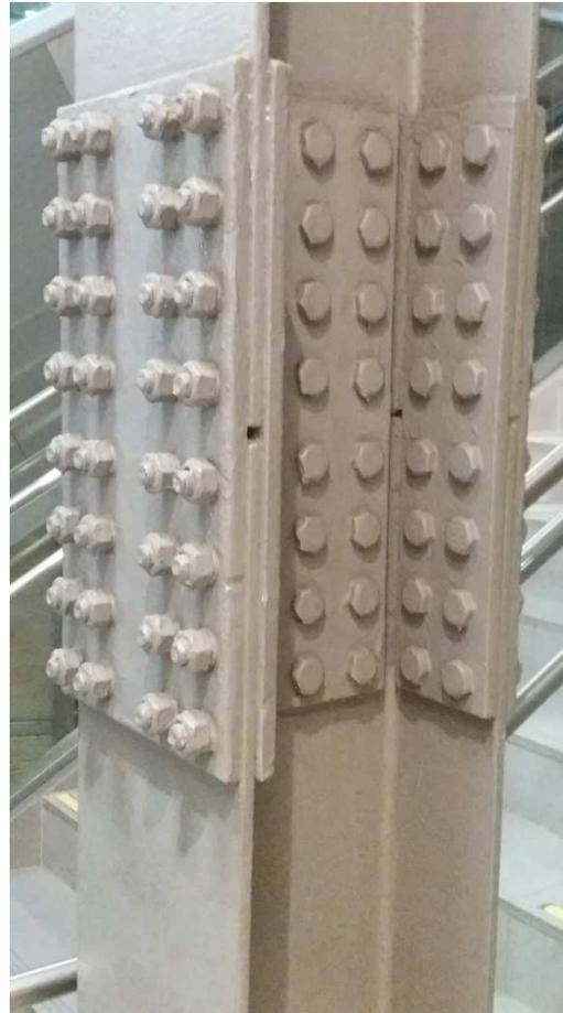
Ligação parafusada unindo parte superior e inferior de uma coluna.
