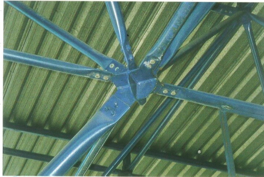
Detalhe de um nó da treliça (fotografia de Anderson Glauco Benite)
