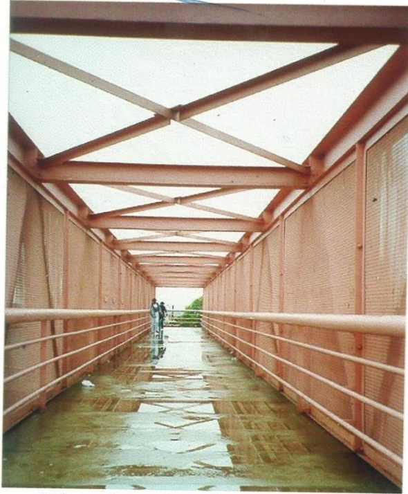
Vista interior da passarela
