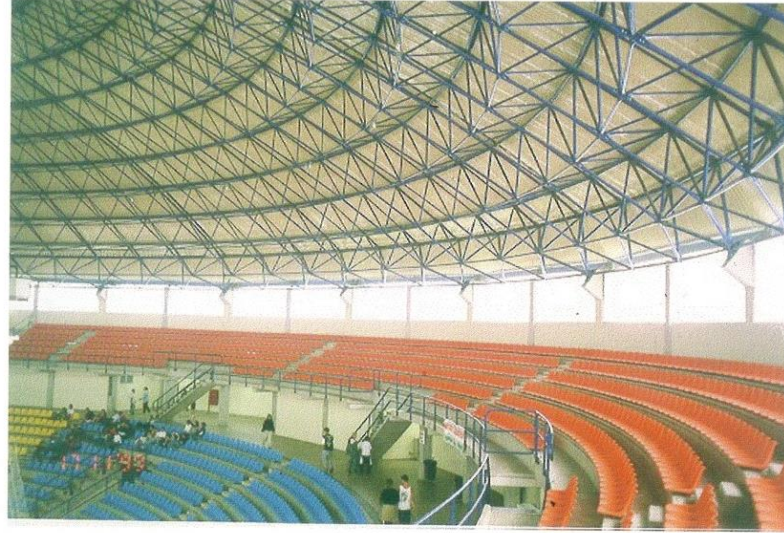
Detalhe dos apoios da cobertura (fotografia de Nayra Tais Savordelli)
