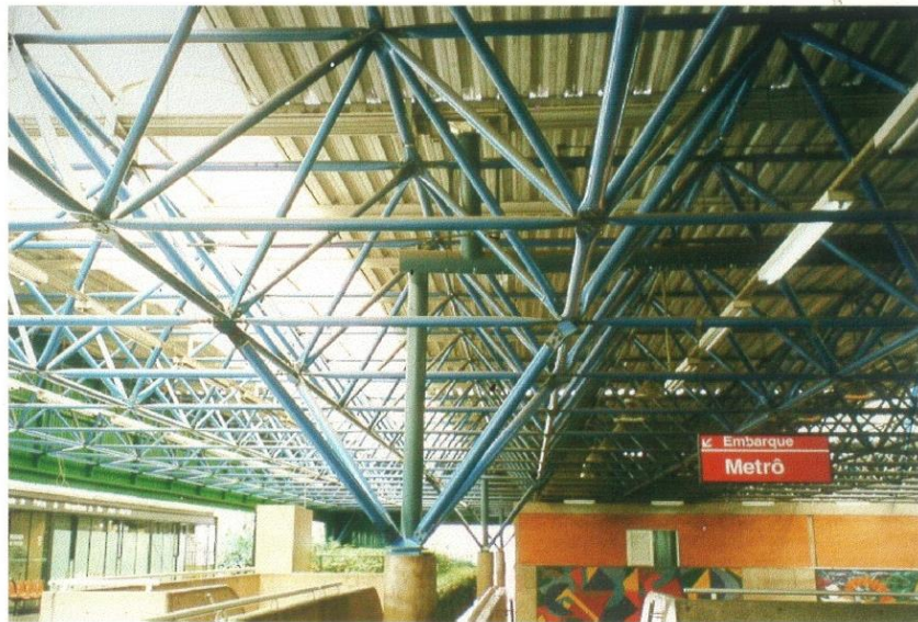
Cobertura da Estação Terminal Barra Funda do Metrô (fotografia de André Hiroshi de Oliveira Nishina)
