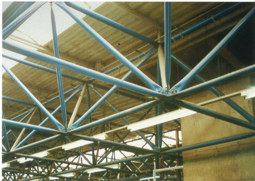
Detalhe de um nó da treliça (fotografia de André Hiroshi de Oliveira Nishina)
