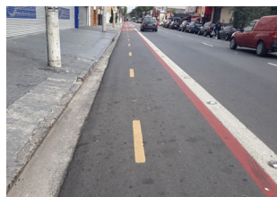
Ciclofaixa Curuçá – Trecho 2
