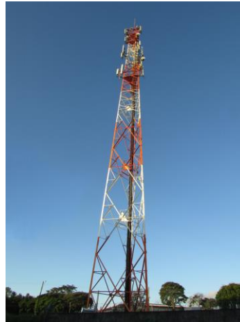
Figura 1 - Típica torre de telecomunicação
