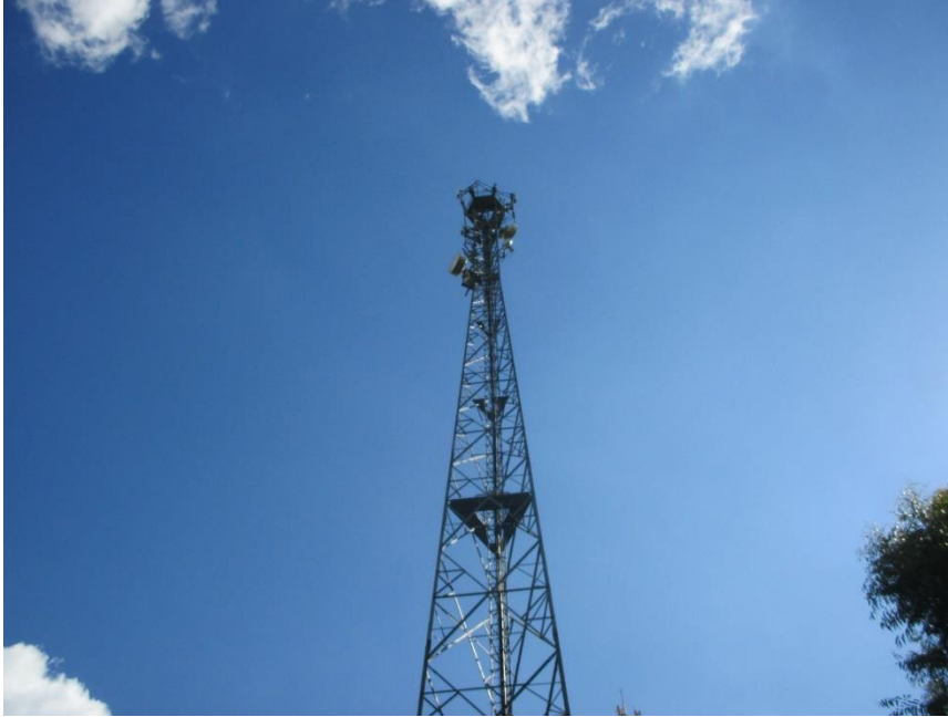
Figura 8.1 – Típica torre de telecomunicação
