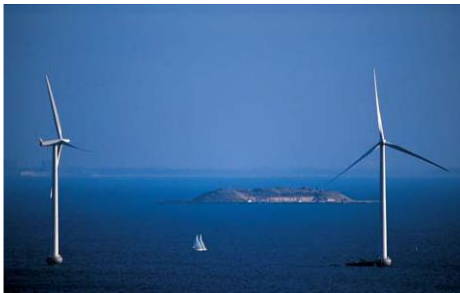
Figura 7.4 – Torre de turbina eólica
