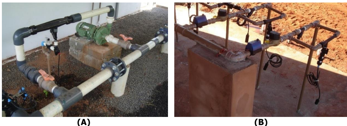
Figura 7. Sistema de fertirrigação utilizando injetor venturi (A) Bastos (2008), e (B) NaanDan Jain (2021).
