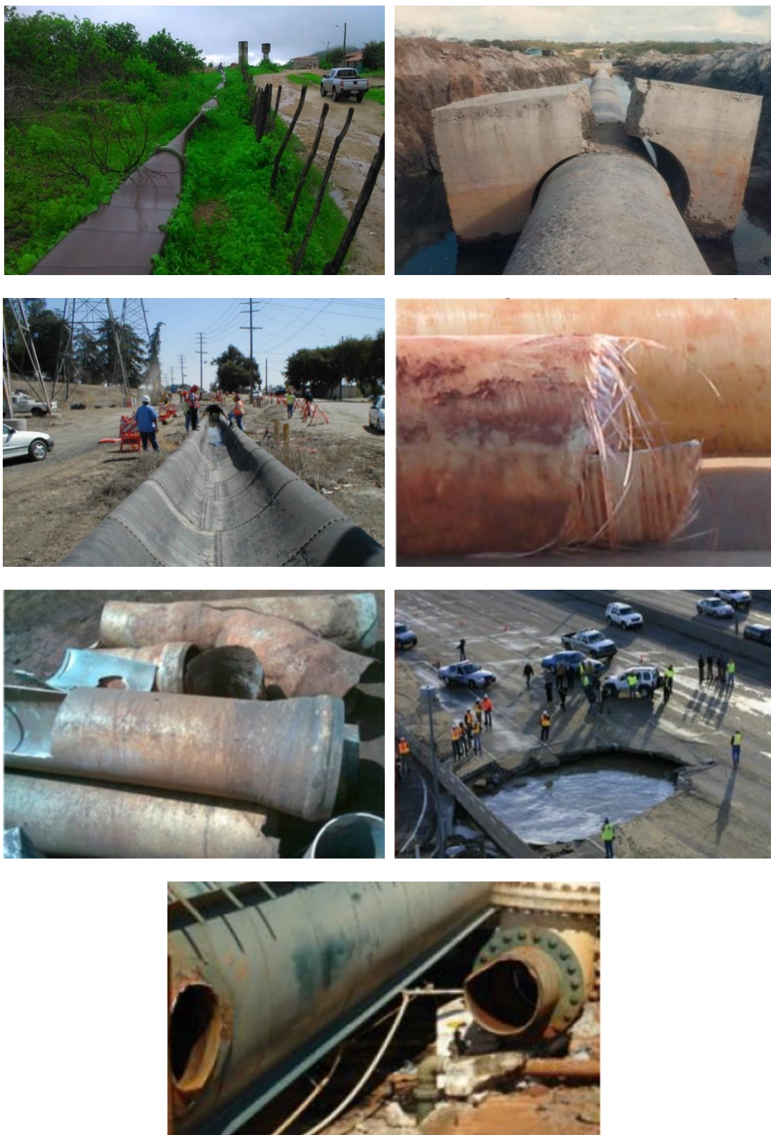
Figura 2. Distintos problemas em tubulações adutoras em função de problemas relacionados aos transientes hidráulicos.
