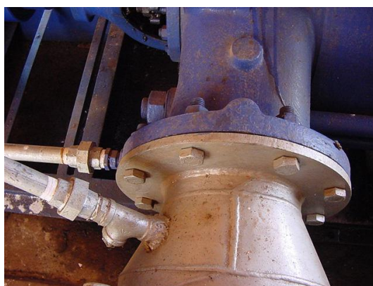
Figura 5. Injeção de fertilizantes diretamente na tubulação de sucção de motobomba utilizada na pressurização de sistemas de irrigação.
