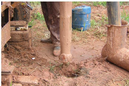
Foto 5.9. Detalhe do cravador dinâmico utilizado para a perfuração dos poços, em Fevereiro de 2006.
