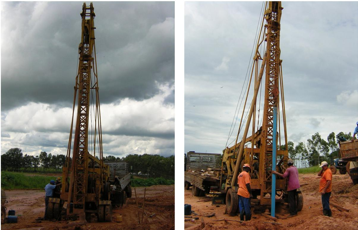
Foto 5.8. Poço de monitoramento sendo construído no aterro de resíduos sólidos de Bauru, em Fevereiro de 2006.
