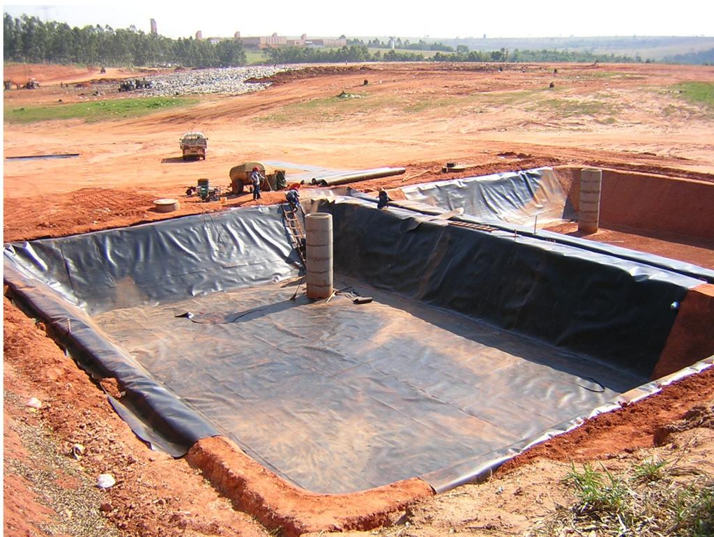
Foto 4.5. Vista geral das lagoas de chorume sendo impermeabilizadas com geomembrana (Agosto, 2007).
