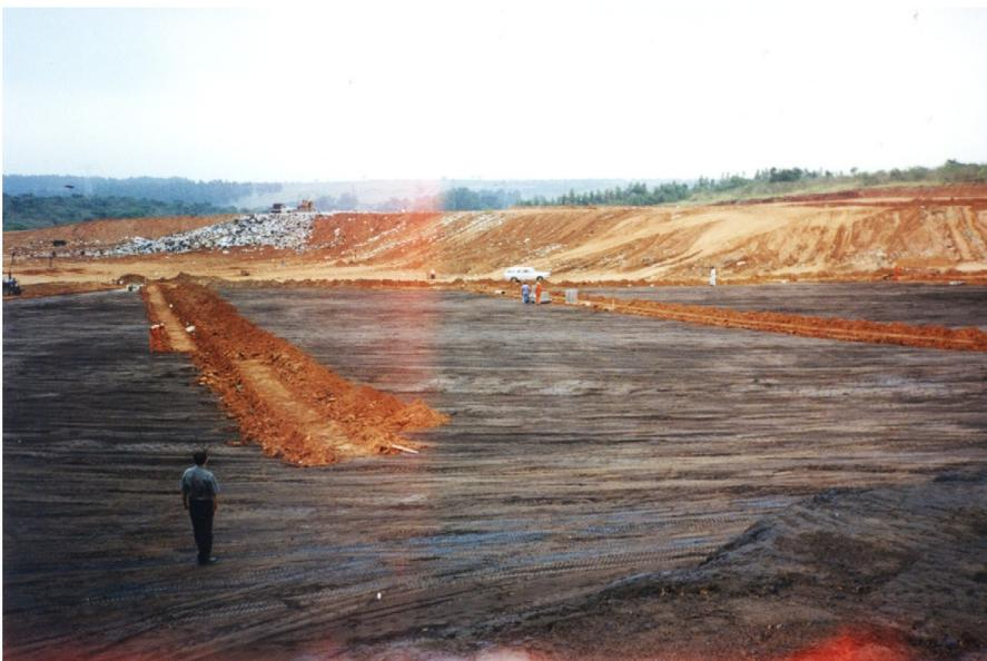
Foto 4.1. Preparação da base do aterro: a) compactação do solo; b) aplicação de imprimação betuminosa.
