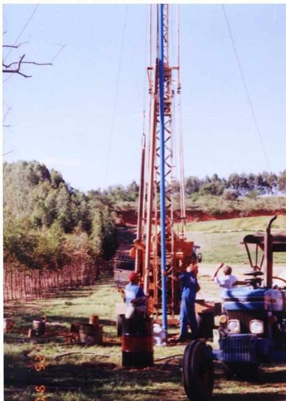
Foto 5.7. Poço de monitoramento sendo construído no aterro de resíduos sólidos de Bauru em Setembro de 2002.
