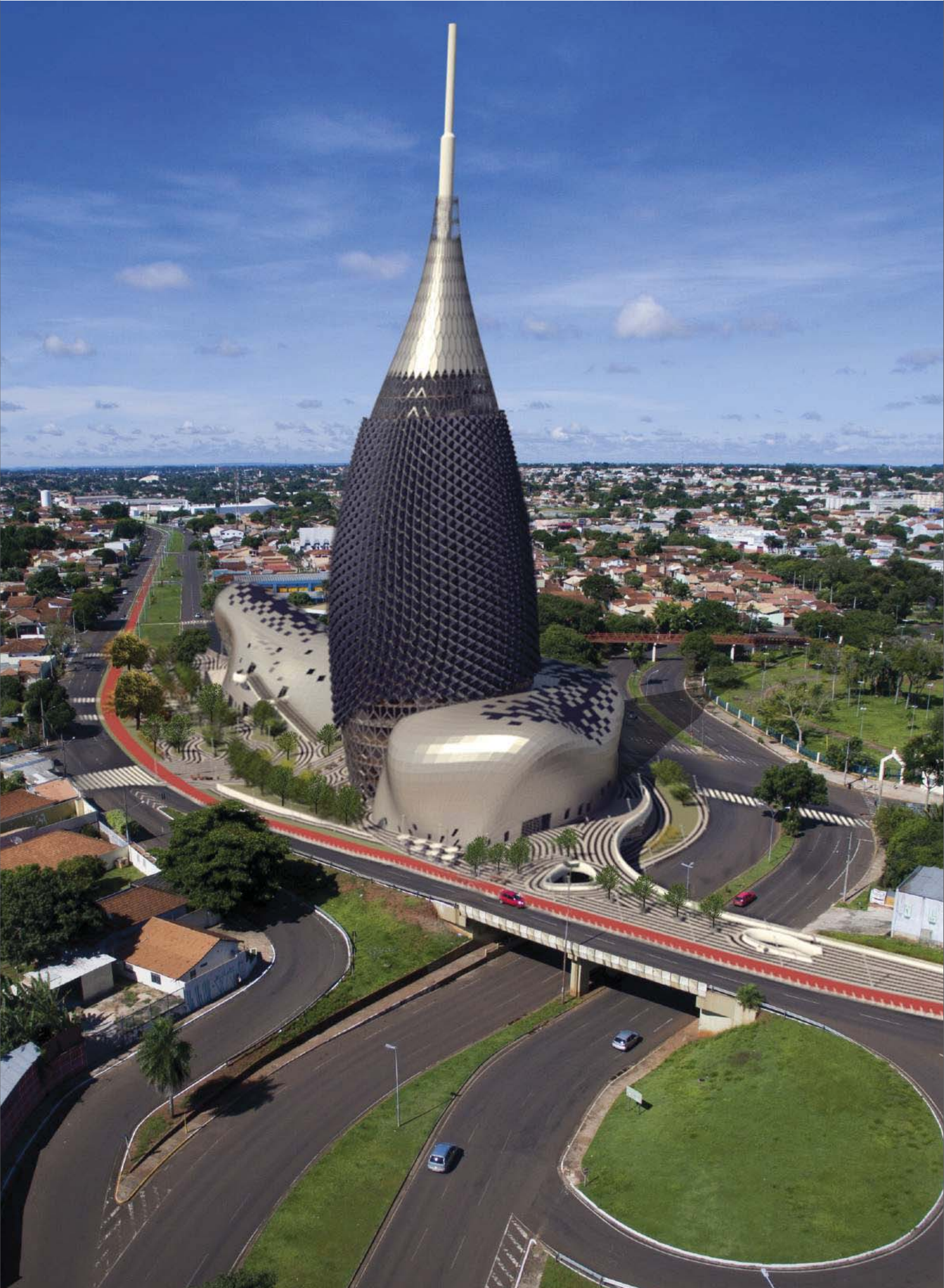
ENCONTRO DA AV. FÁBIO ZAHKAN COM AV. FERNANDO CORRÊA DA COSTA
