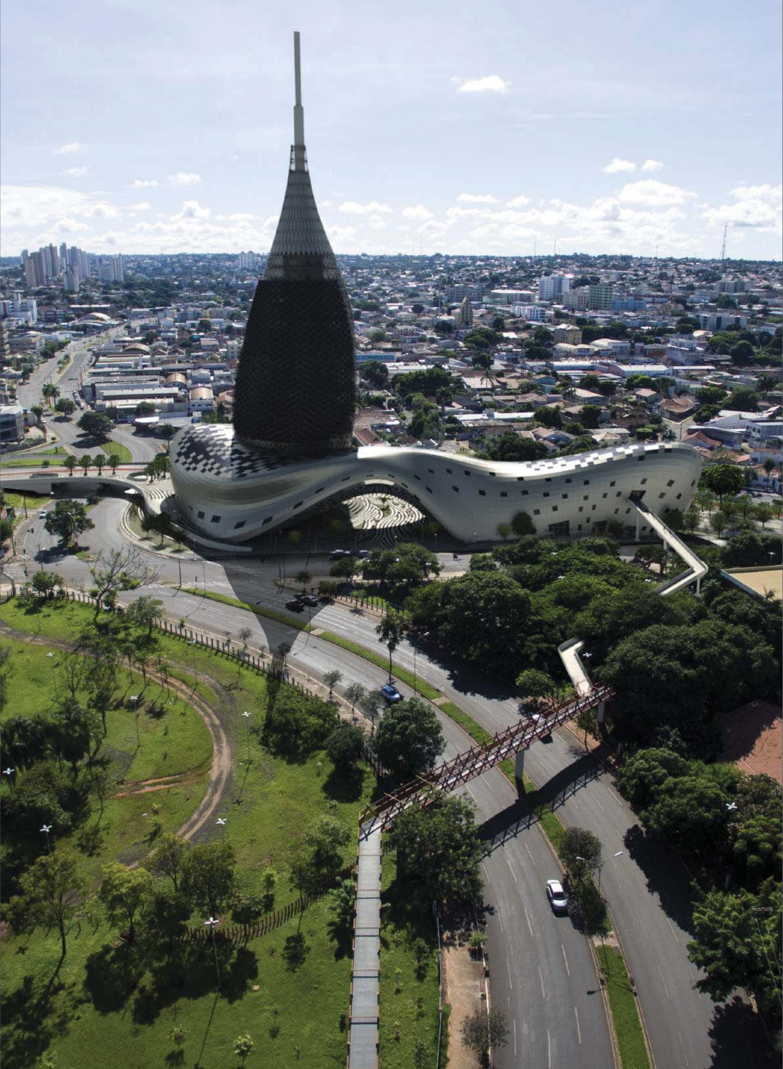
FACHADA OESTE E A CONEXÃO COM A PASSARELA DO HORTO FLORESTAL
