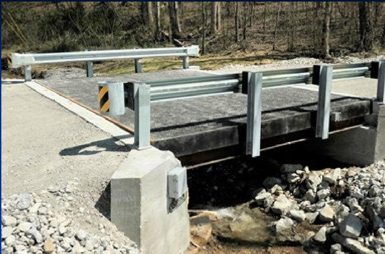
*Ponte composta desenvolvida pela Structural Composites e instalada no centro-norte do Tennessee.*
