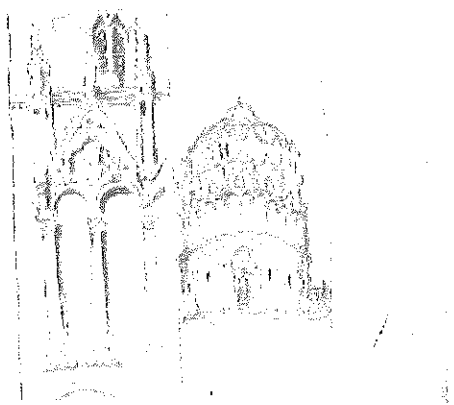
Figura 02: vista e detalhe do Batistério. Pisa, 1907. Fonte: CORBUSIER, Le, 1987 apud LANCHA, 2006.
