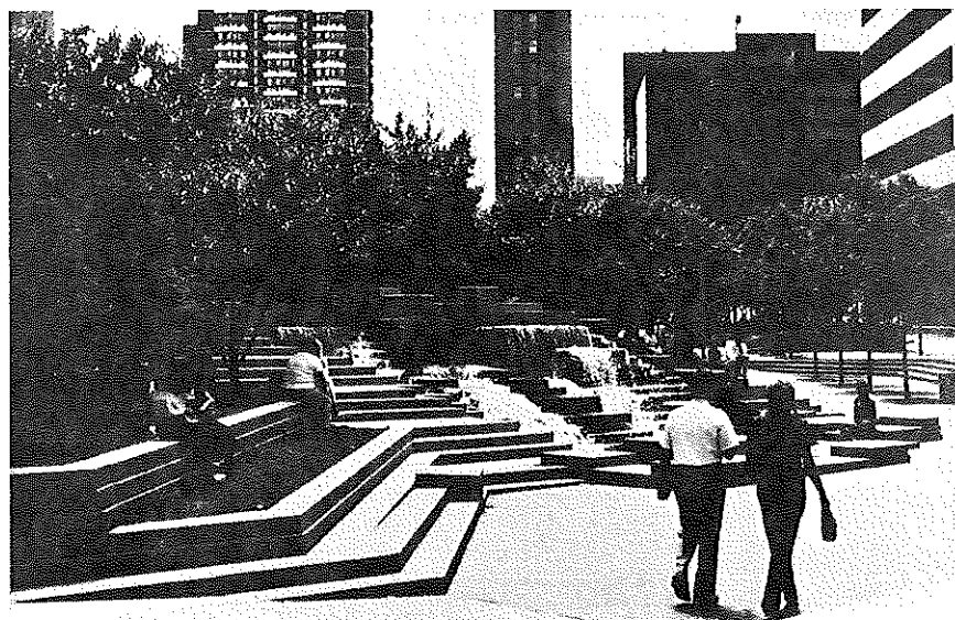
Fig. 7.9. A Skyline Plaza, no centro de Denver, armazena vários milímetros de água das chuvas, liberando-a gradualmente. Existe lugar para a retenção das águas das chuvas, mesmo nas partes mais congestionadas da cidade.
