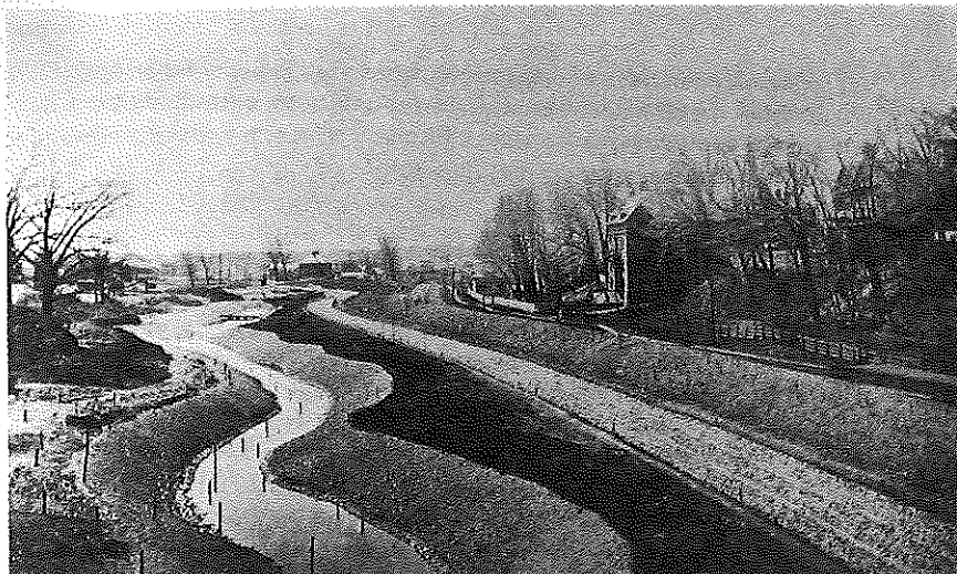
Fig. 7.2. O Riverway, Boston, cerca de 1892, mostra as margens niveladas prontas para o plantio. À direita, uma elevação separa o parque da recém-instalada linha de bonde.
