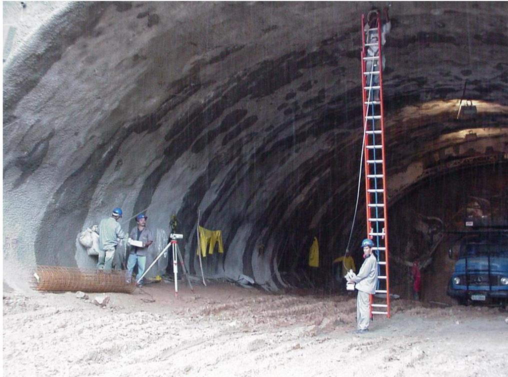
*Vista de leitura do medidor de convergência –
