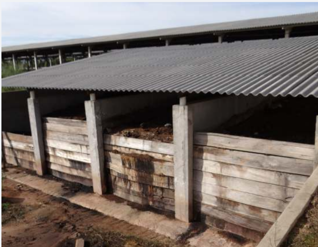
Figura 7. Células de compostagem tradicional para tratamento de carcaças de animais mortos em granja comercial de suínos. Ao contrário do que se observa na imagem, recomenda-se que as células possuam canaletas para coleta do chorume e telas para evitar a entrada de pássaros e insetos.
