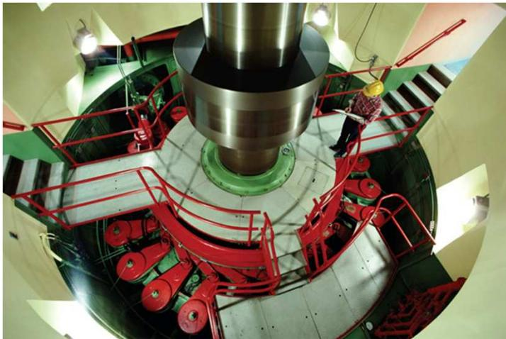
Figura 1. Eixo de um gerador para transmissão de potência.
