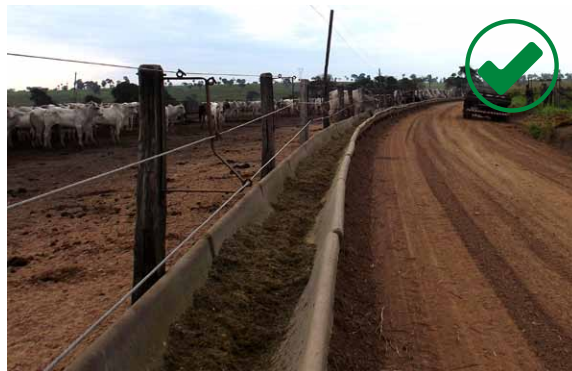
CURRAL E VIA DE ACESSO EM BOAS CONDIÇÕES.
