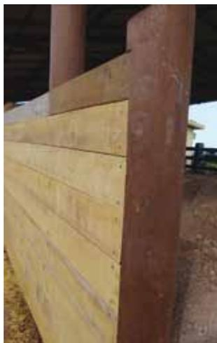
PARAFUSOS ENCAIXADOS NA MADEIRA
