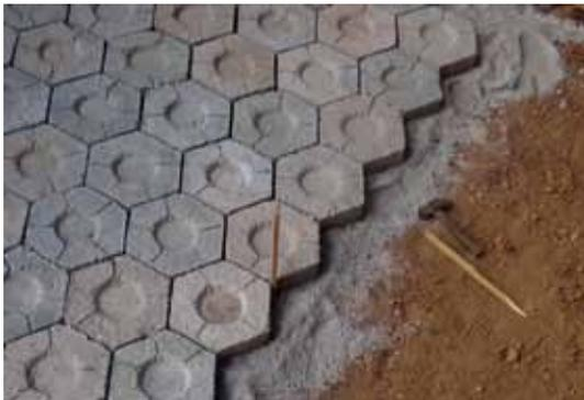
PISO DE BLOQUETE DE CONCRETO COM ESTRUTURA ANTIDERRAPANTE
