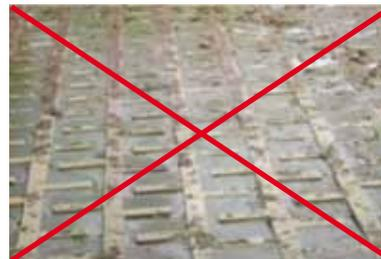
PISO COM ESTRUTURAS ANTIDERRAPANTES QUE NÃO PERMITEM O ESCOAMENTO DE ÁGUA.
