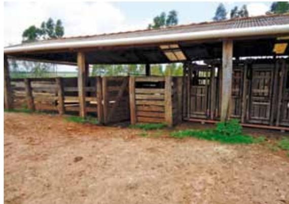
A PRESENÇA DE CALHA MINIMIZA A FORMAÇÃO DE LAMA
