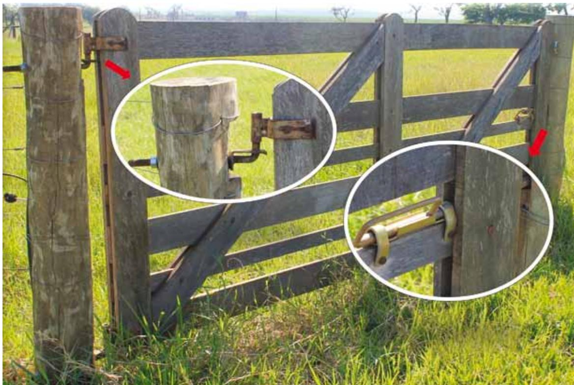
PORTEIRA, COM DESTAQUE PARA A DOBRADIÇA TIPO BOCA DE LOBO E PARA O TRINCO COM FERROLHO CENTRAL
