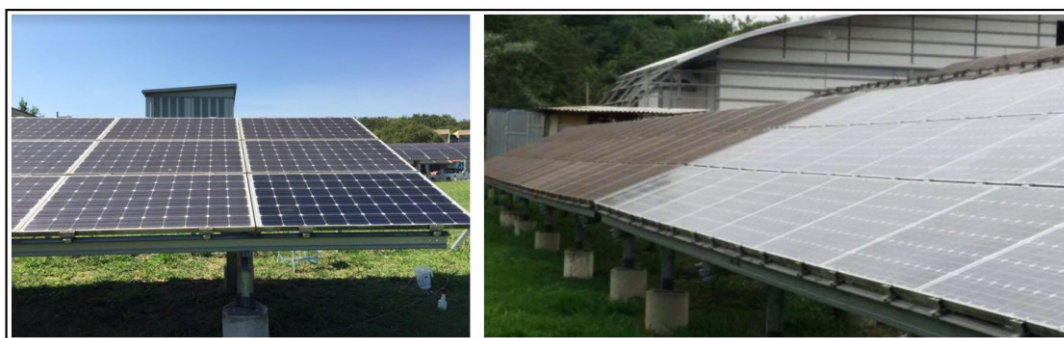
Figura 4.4 - Comparação entre módulos limpos e sujos com mais de 30 meses de sujidade acumulada. Fonte: Acervo do Autor, 2016.
