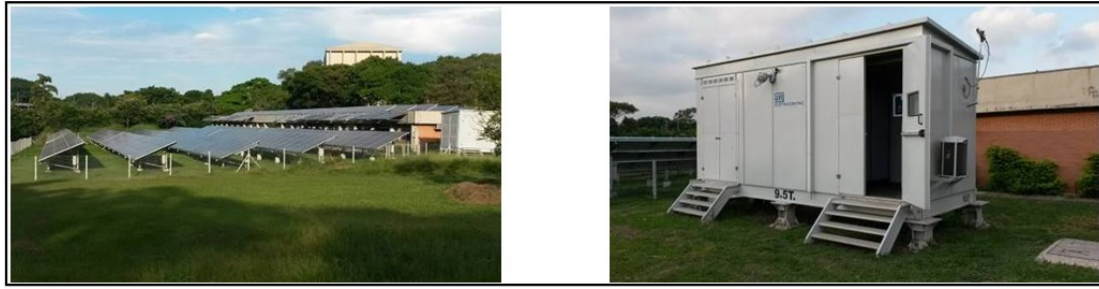
Figura 2.10 - Gerador fotovoltaico (esquerda) e eletrocentro (direita) do subsistema CTPV. Fonte: ALMEIDA et al , 2016.
