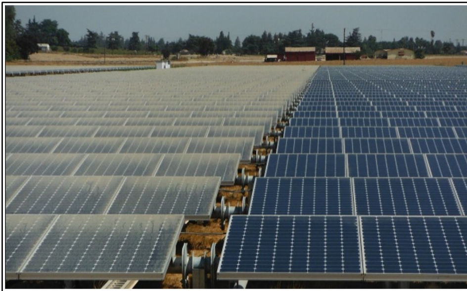
Figura 0.5 - Sujidade em painéis de plantas solares. Fonte: COBB, 2014.
