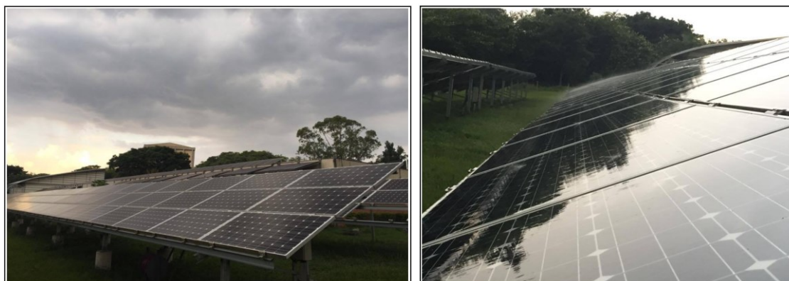
Figura 4.11 - Módulos da mesa 7 no dia 21 de fevereiro de 2017, sendo a primeira imagem antes de iniciar o procedimento de limpeza e a segunda durante a limpeza em momentos de chuva moderada. Fonte: Acervo do Autor, 2017.
