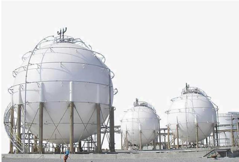
Fig.3: Colunas de sustentação de vaso para armazenamento de gás (LNG) e barras para contraventamento.
