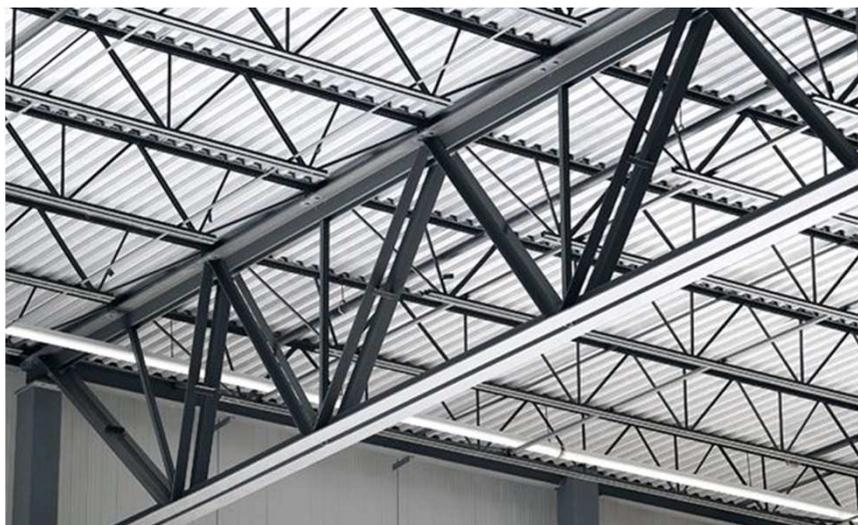
Fig.1: Treliça metálica formando uma cobertura:
