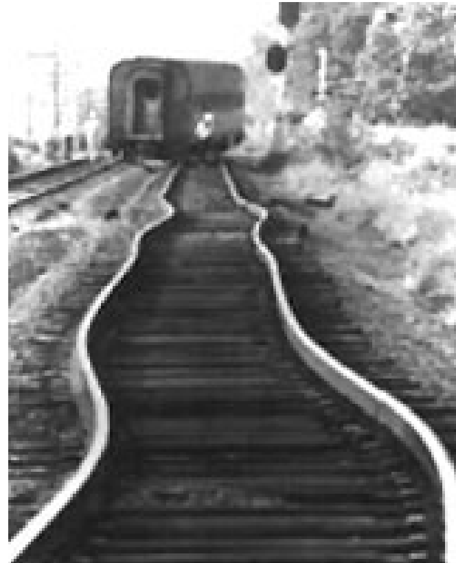
Trilhos contínuos: não cabem no espaço original (empenamento)
