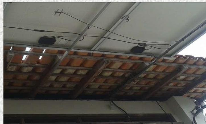
Sensores de temperatura ambiente e do módulo
