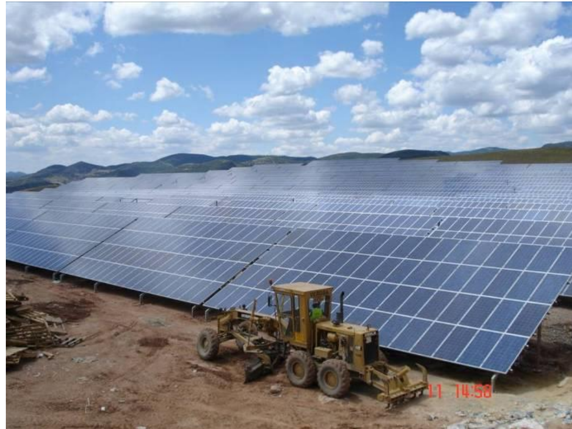
4 MW em Jaén, Espanha
