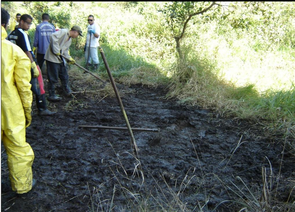
Remoção do solo atingido por ácido, já neutralizado. Trabalhos manuais.
