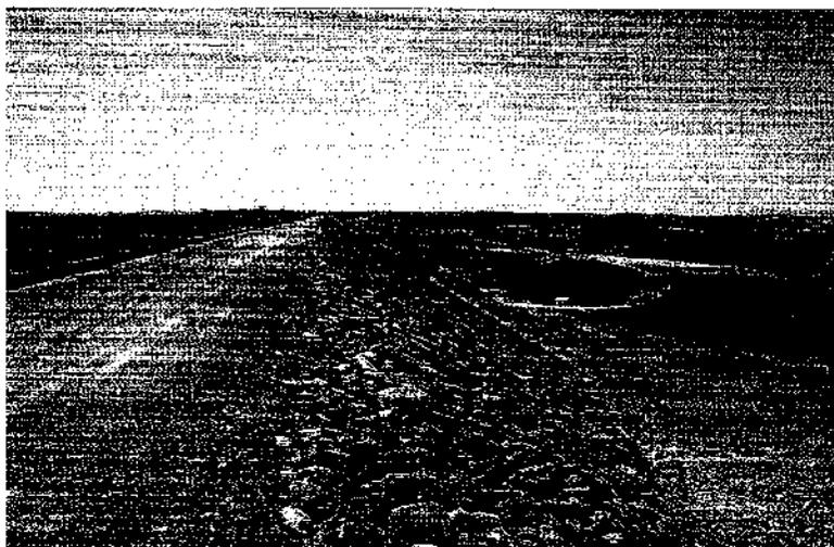
*Fig. 13.9 Barragem de rejeitos da mina Neves Corvo, Portugal, com função de armazenar à perpetuidade os resíduos provenientes do tratamento de minério; à esquerda, vê-se a bacia de rejeitos, permanentemente coberta de água para prevenir a formação de drenagem ácida; ao mesmo tempo que é uma medida mitigadora, uma barragem de rejeitos é um componente do projeto que demanda grande atenção para o gerenciamento de riscos*
