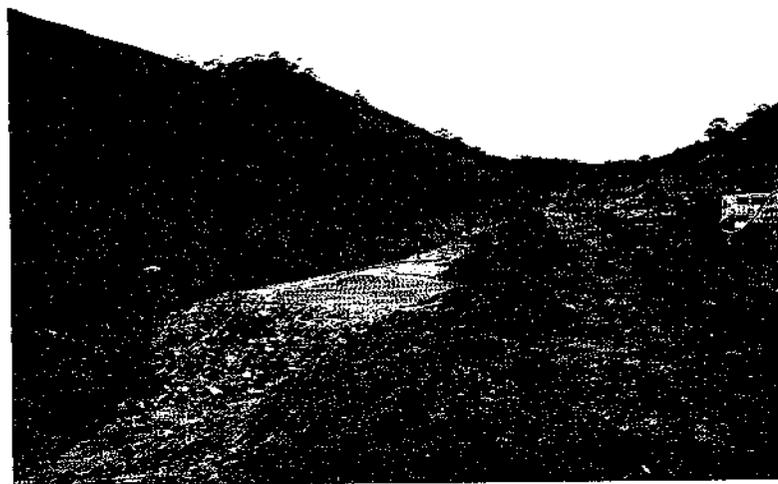
Fig. 13.8 Pequenas bacias de retenção de sedimentos provenientes de áreas de terraplenagem e proteção com grama de talude em solo, realizada imediatamente após a conclusão dos trabalhos de escavação, são medidas que reduzem a degradação da qualidade das águas superficiais. Construção da pista descendente da rodovia dos Imigrantes, SP
