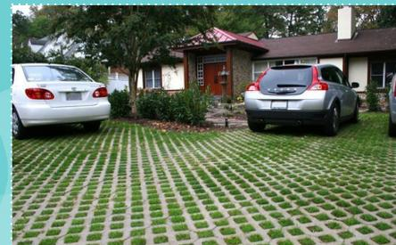
Consiste em uma estratégia para reduzir a impermeabilidade das superfícies urbanas, permitindo a infiltração das águas pluviais. São benéficos por reduzir o escoamento superficial e, por consequência, as inundações. Podem ser usados em calçadas, vias, estacionamentos, pátios, quintais, parques e praças. Entre os materiais utilizados estão o asfalto poroso, concreto permeável, blocos intertravados, brita e pedriscos.
