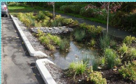
São jardins em cotas mais baixas que recebem as águas da chuva de superfícies impermeáveis adjacentes. Podem ser feitos com facilidade e se integram de forma eficaz os sistemas de drenagem urbanos. Além de deter a água e reduzir fluxos em bueiros e canais, também purificam as águas pluviais que são lançadas nos cursos e ajudam na manutenção da biodiversidade, aumento da evapotranspiração, moderação da ilha de calor e captura de C.
