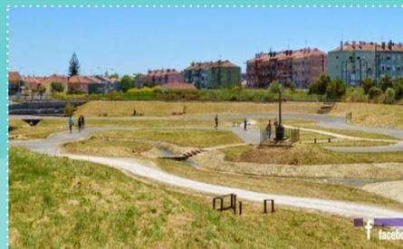
É uma depressão vegetada que recebe as águas quando chove. Ela ajuda na redução da vazão superficial e retarda a entrada de águas no sistema de drenagem possibilitando a infiltração com a recarga aquífera. Pode ser projetada em diversos pontos da bacia de drenagem, como ao longo de vias, rios, parques lineares, jardins públicos, entre outros. Em épocas secas, pode ser utilizada para atividades diversas e de lazer, como, por exemplo, campo de futebol.
