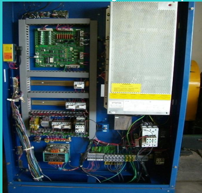
Fotografias de um painel de comando eletromecânico para elevadores.
