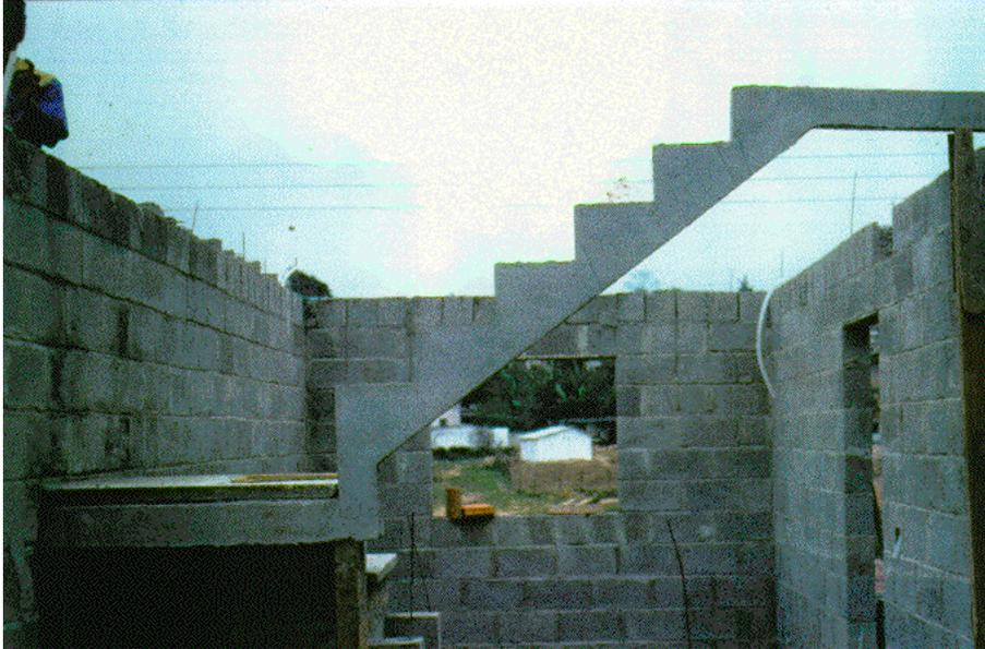
*Figura 39 Viga da escada. "Mutirão Sônia Ingá"*
