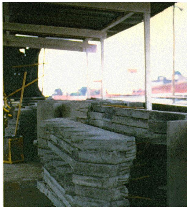
*Figura 36 Viga "Jacaré" em concreto armado*
