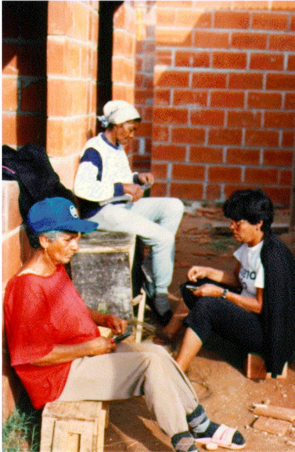
*Figura 25 Associação "Projeto União". Mulheres preparando elementos para a montagem de armaduras.*
