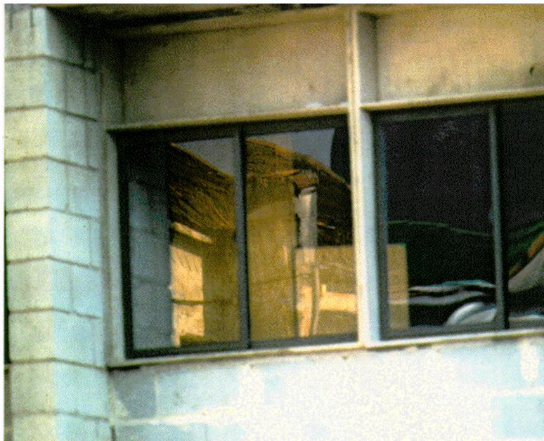
*Figura 91 Caixilhos pré-fabricados em argamassa armada, especialmente para o projeto.*
