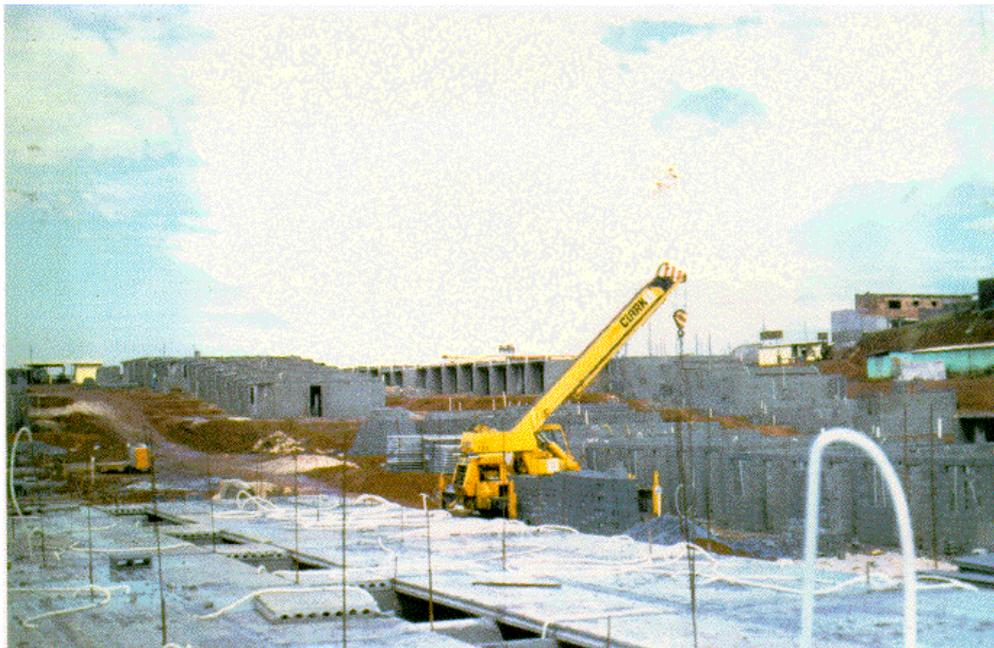
*Figura 30 Guincho usado para a montagem da laje. "Mutirão São Francisco"*
