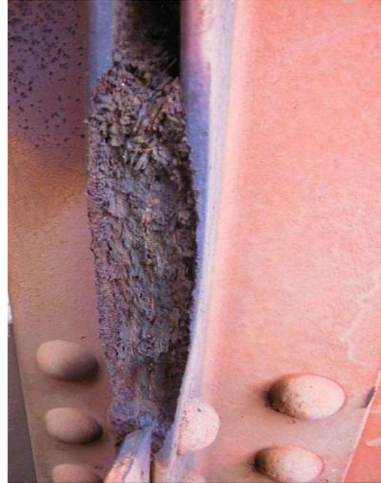
Fresta formada entre duas paredes metálicas em contato
