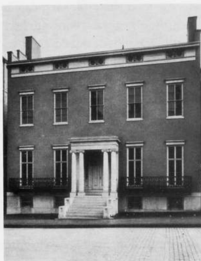
Baltimore, casa no 107 West Monument Street (início do século XIX).
