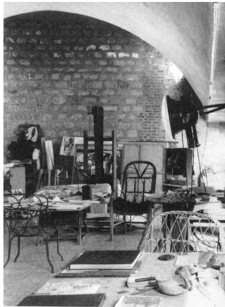
Fig. 15 Parede em pedra e tijolos no ateliê de Le Corbusier, 1931- 34, rue Nungesser- et-Coli, Boulogne- sur-Seine.
