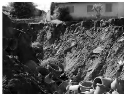
**Figura 14.13** Erosão em área urbana causada por problemas na drenagem de águas pluviais (Cidade de Ribeirão Bonito – SP). Foto dos autores.
