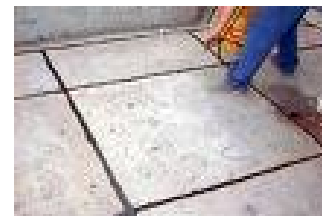
juntas de dilatação
