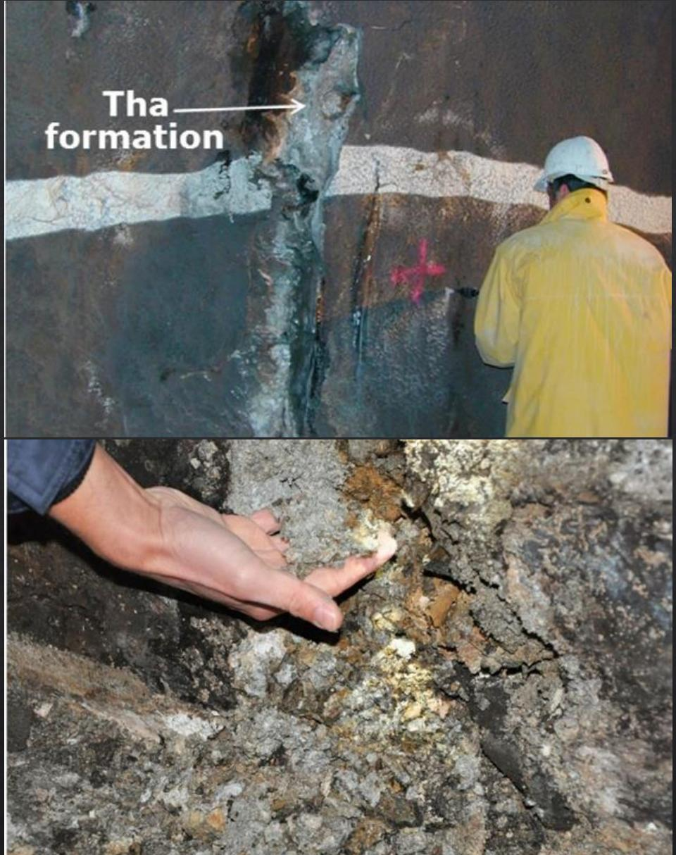
Formação de taumasita e degradação do concreto em túnel austriaco.
