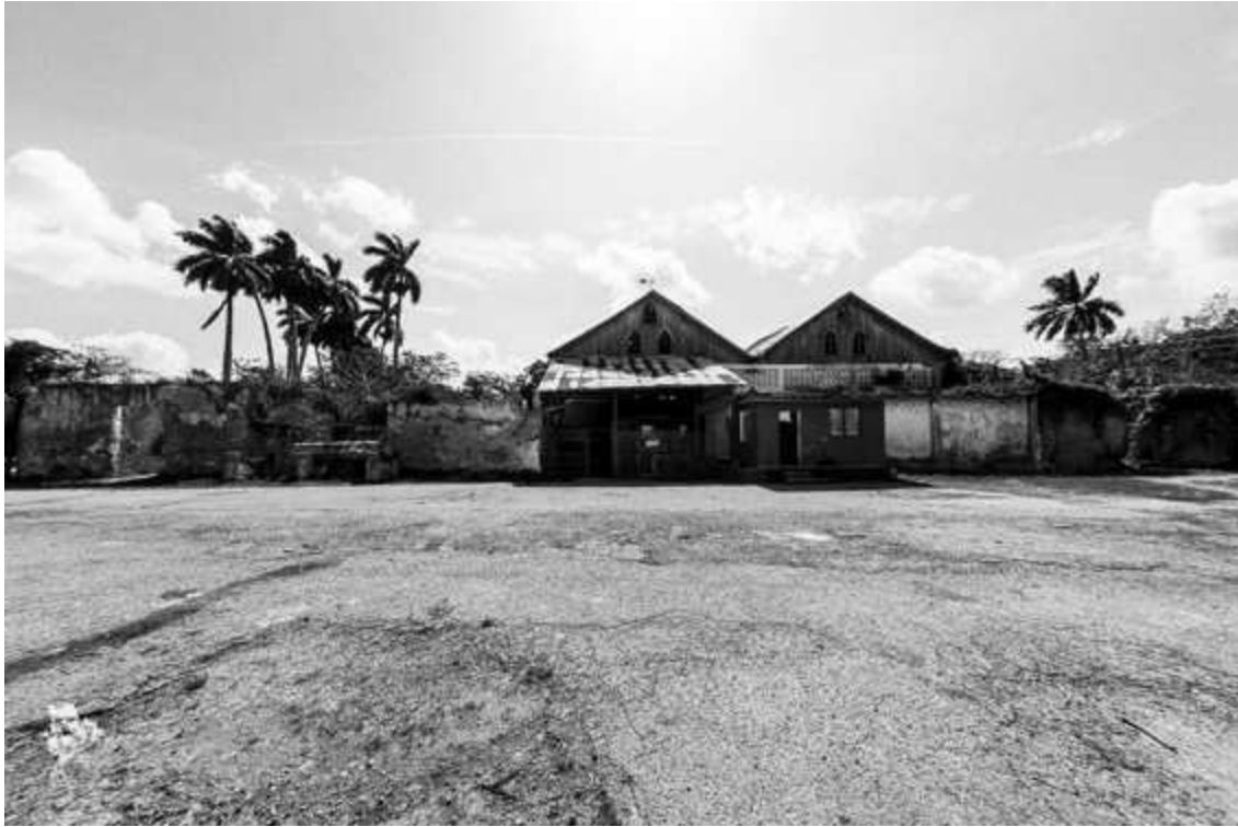
A atual fábrica de gelo, ao centro, funciona sob os dois telhados. De ambos os lados, fundações e paredes remanescentes da antiga casa-grande do Engenho Los Molinos, em Matanzas.
