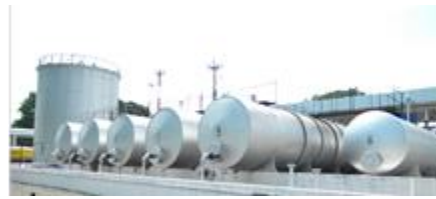
Figura 18 - Armazenamento de querosene de aviação
