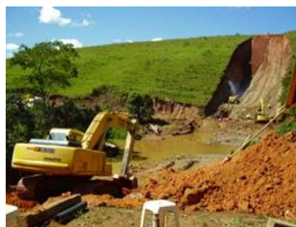
Figura 29 - Abertura de vala em encosta para assentamento de duto
