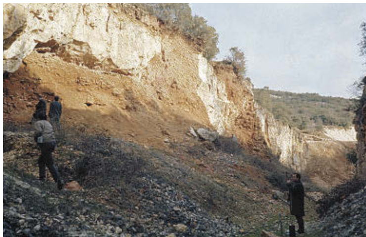
Trinchera Galería en 1963. Foto: J.L. Uribarri
