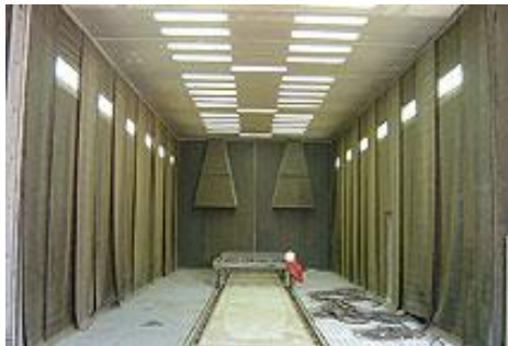
Cabines de jateamento abrasivo
