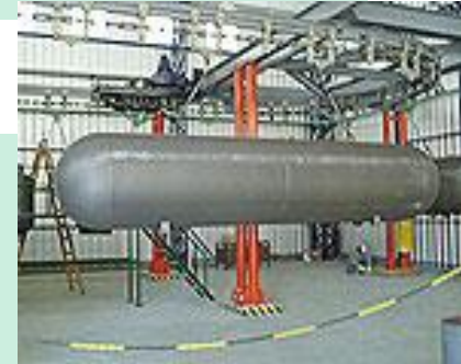
Jateamento de um reator (parte externa)
