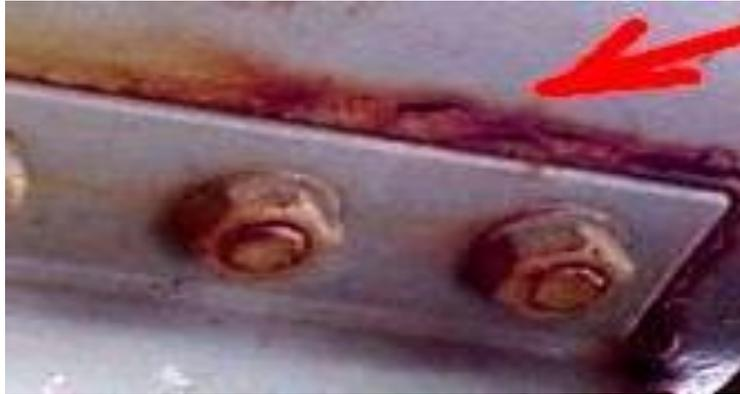
Corrosão em fresta formada na junção de duas chapas de aço zincado
