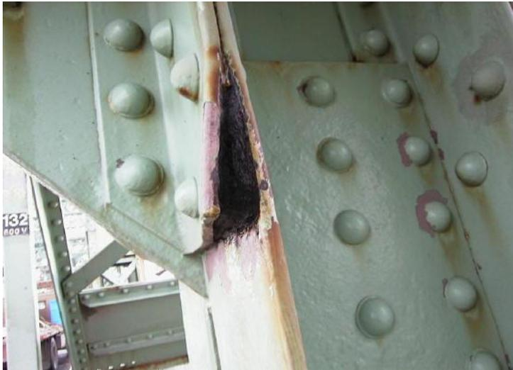
Corrosão em fresta formada pela junção de duas chapas metálicas. Houve retenção de eletrólito entre elas.
